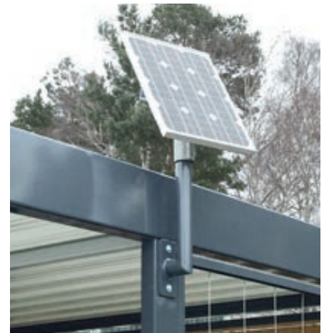
▲ Solarmodul an Warthallenstütze befestigt
